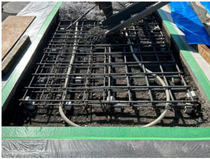
斜め鉄筋、空のCD管を設置し探査のテスト場としても活用します。
