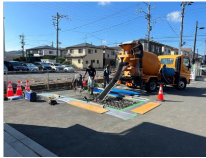
コンクリ流し込み打設作業風景、弊社社員もやってみました。
