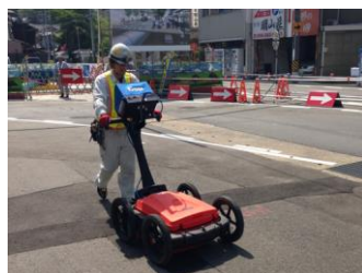
高性能地中レーダ探査機の探査状況。
